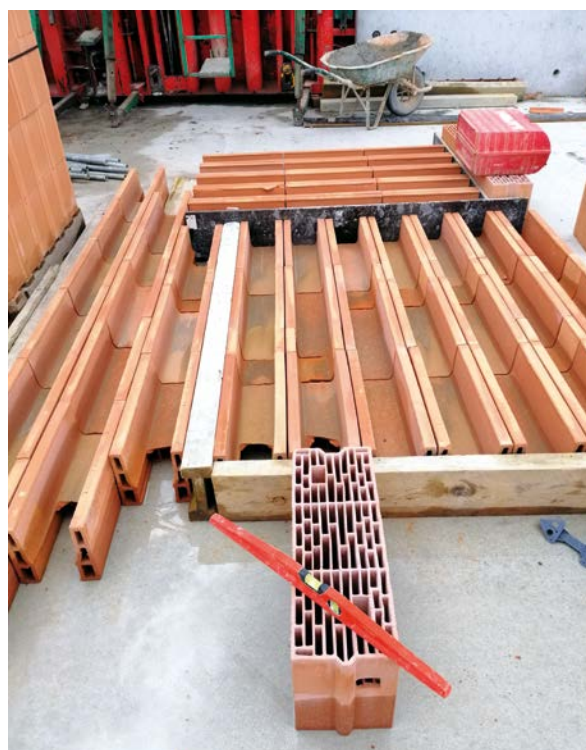
Initiative de coulage des linteaux au sol ►
