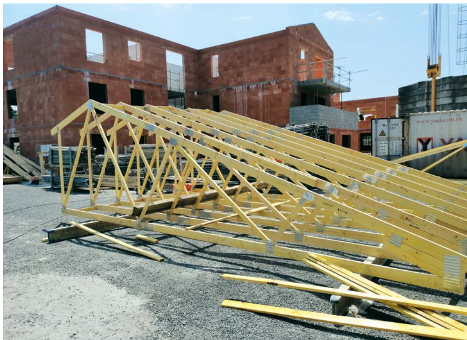
▲ Montage de charpente au sol
