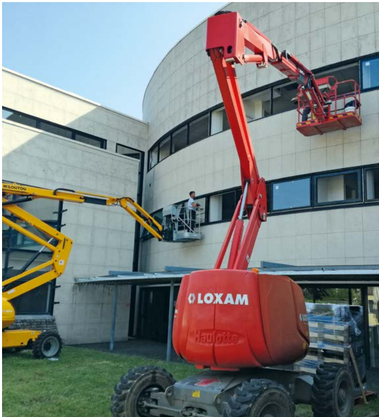
▲ Pose des châssis de menuiserie sur mesure à la nacelle
