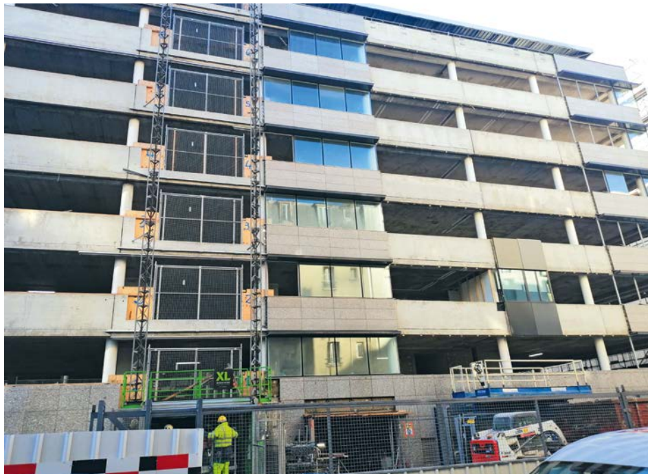
▲ Ascenseur de chantier pour l'approvisionnement en étage
