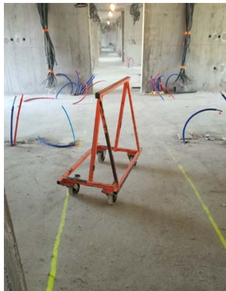
Matérialisation des circulations et mise à disposition de chariot pour les approvisionnements ►
