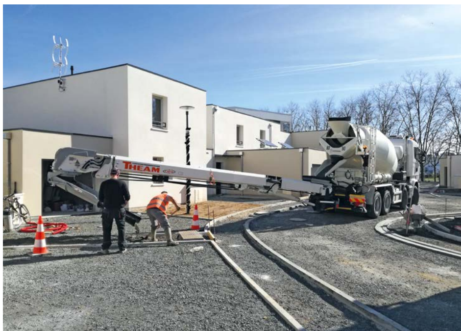
▲ Méthode de chantier optimisée en équipe
