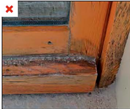
▲ La partie basse de la menuiserie est la plus vulnérable car la plus exposée aux intempéries
