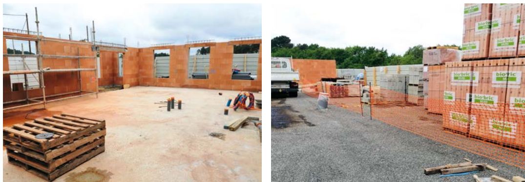
▲ Rangements dans l'espace de travail / Zone de stockage délimitée
